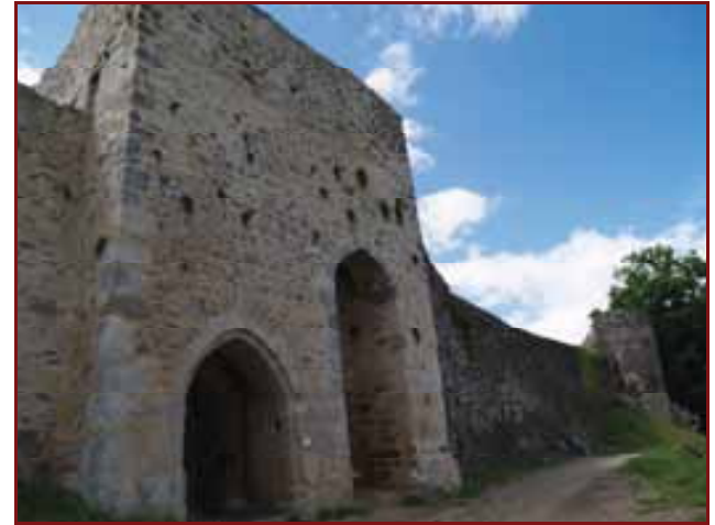
La Porte de Fer restaurée
