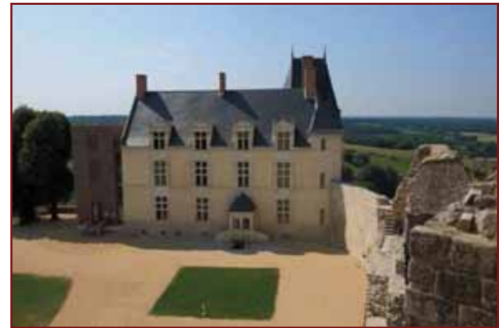
La façade sur cour du logis classique restauré
