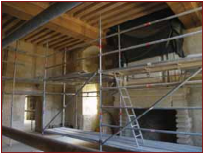
Modification des niveaux de plafond
