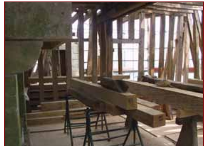
Restauration intérieure de la tour sud
